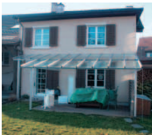
Toiture de veranda
